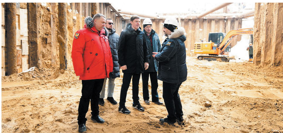
Глава г.о. Люберцы Владимир Волков проверил строительство подземного перехода через Октябрьский проспект.
